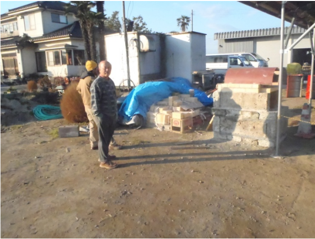
ピザ窯作成中。試してから年内に稼働予定。
